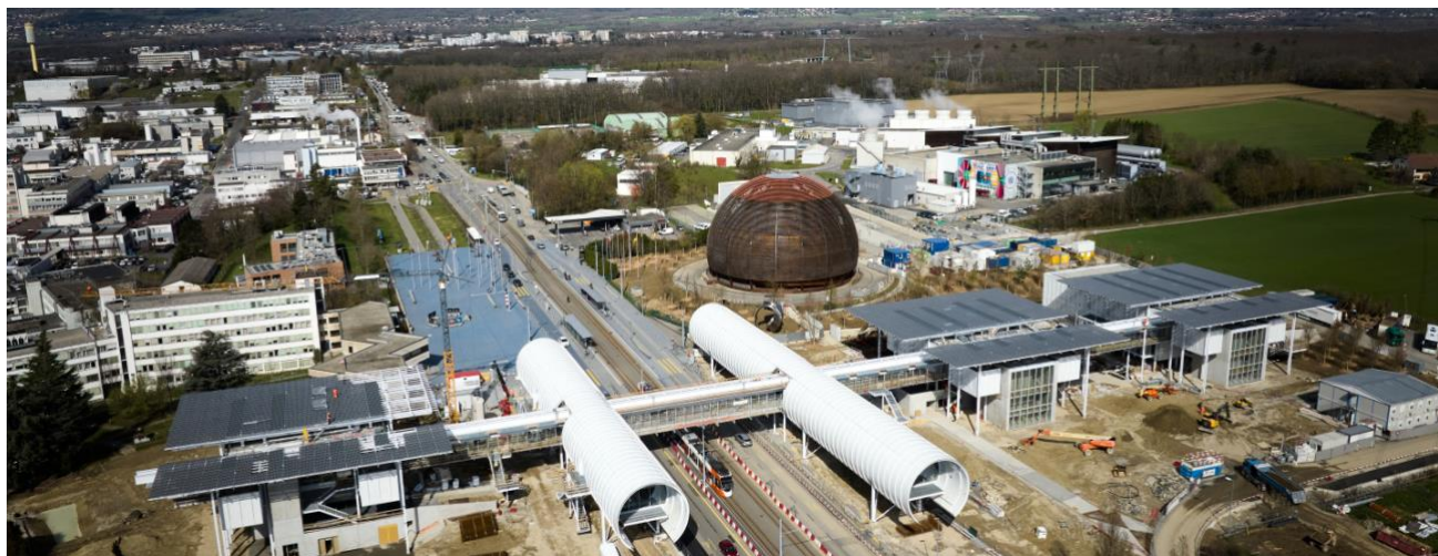
Gli edifici di Science Gateway in costruzione, visti dal drone (©CERN, Febbraio 2023).
